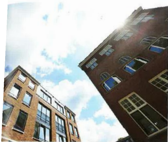
In de buitengevel zijn alle houten kozijnen behouden, maar het enkel glas is vervangen door dubbelglas.
